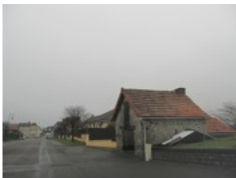
vue d'ensemble depuis la rue, angle sud-ouest
