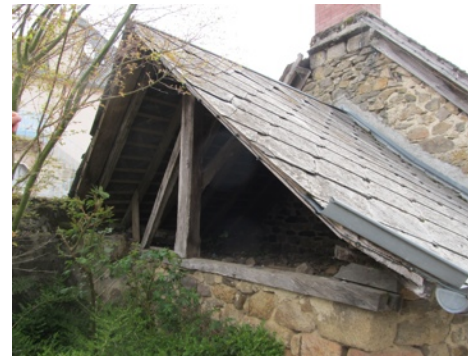
toit du four
