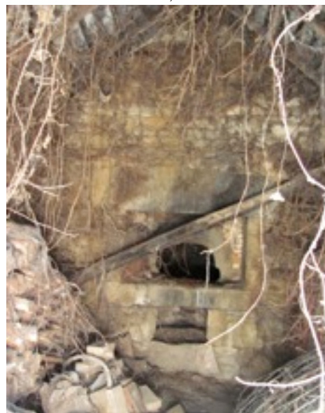
volume intérieur, bouche du four
