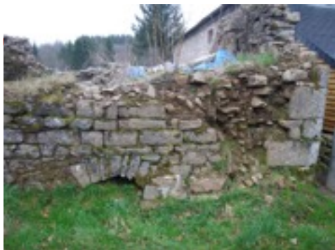
façade nord sur rue
