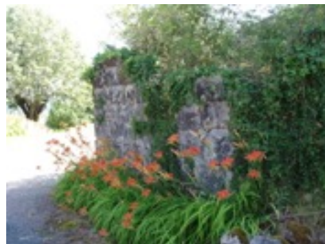
mur gouttereau ouest
