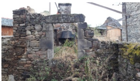
Vue d'ensemble depuis la rue, façade sud
