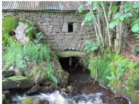
façade ouest, sortie de l'eau
