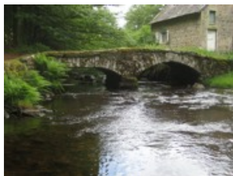
Vue du pont depuis l'étang.
