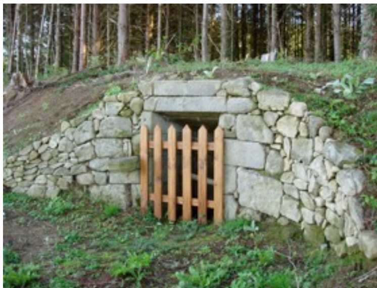
Détail des maçonneries
