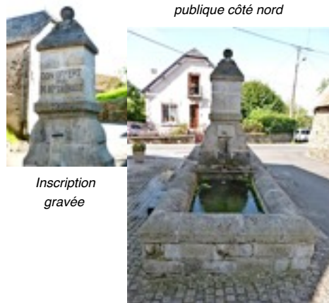
Fontaine vue de la voie publique côté nord
