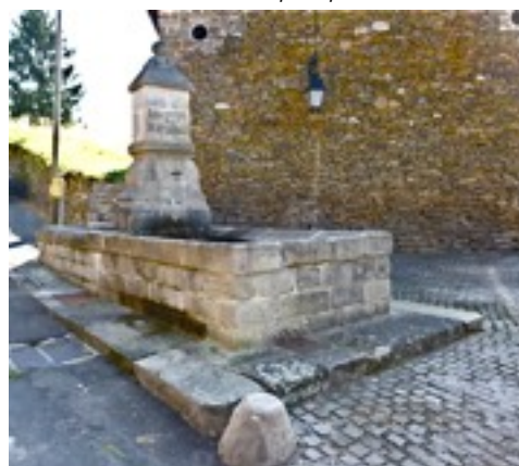
Fontaine vue de la voie publique côté sud
