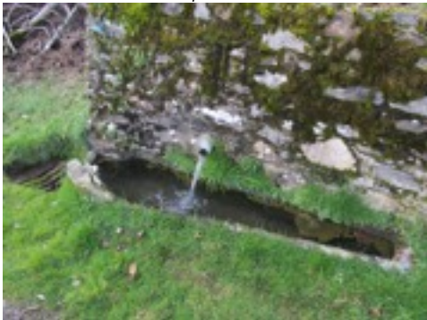
le bac en pied de mur
