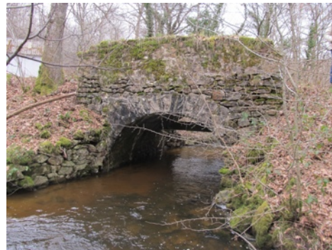
le pont vu depuis l'aval, rive droite
