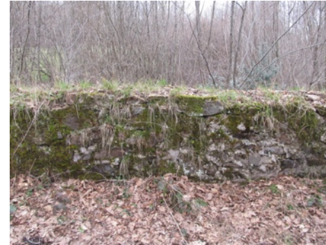
le parapet côté amont
