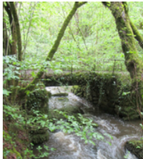
une partie du pont vue de l'aval
