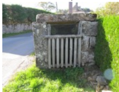
ouverture du puits
