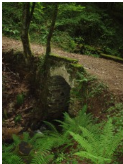
le pont côté amont
