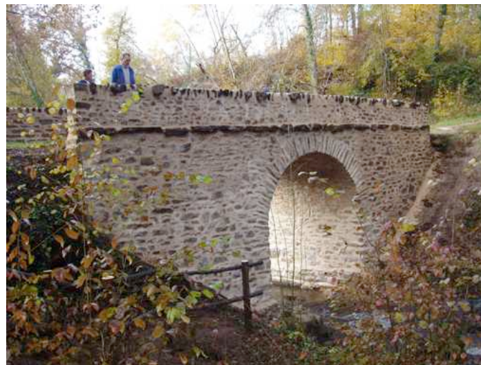
Vues générales après restauration
